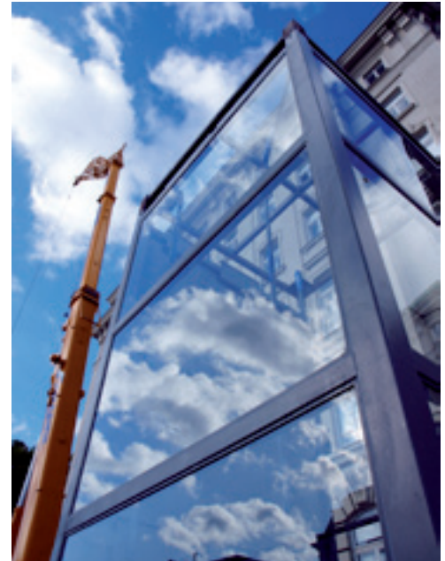
Liftschacht im Hof . Elevator shaft in the courtyard
